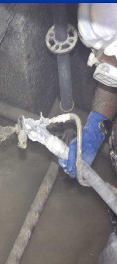
Распылитель Graco Mortar M680™ предназначен для перекачивания широкого спектра абразивных материалов, таких как эпоксидные растворы, нескользящие покрытия, цементирующие материалы, а также полимерных материалов с различными наполнителями (стекловолокно, кремний, песок).
